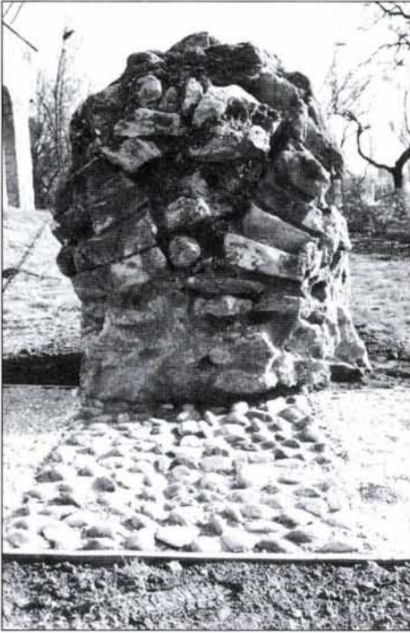
5. kép: Az egykori – 67-es számú – pillér jelzése, a vízkő tömbben maradt eredeti boltvállakkal
