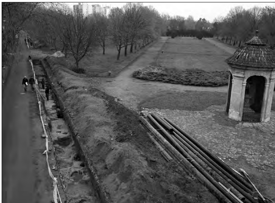
3. kép: Hugonmai Vilma utca, munkafotó az ásatási területről Fig. 3: The excavation site at Hugonmai Vilma St.
