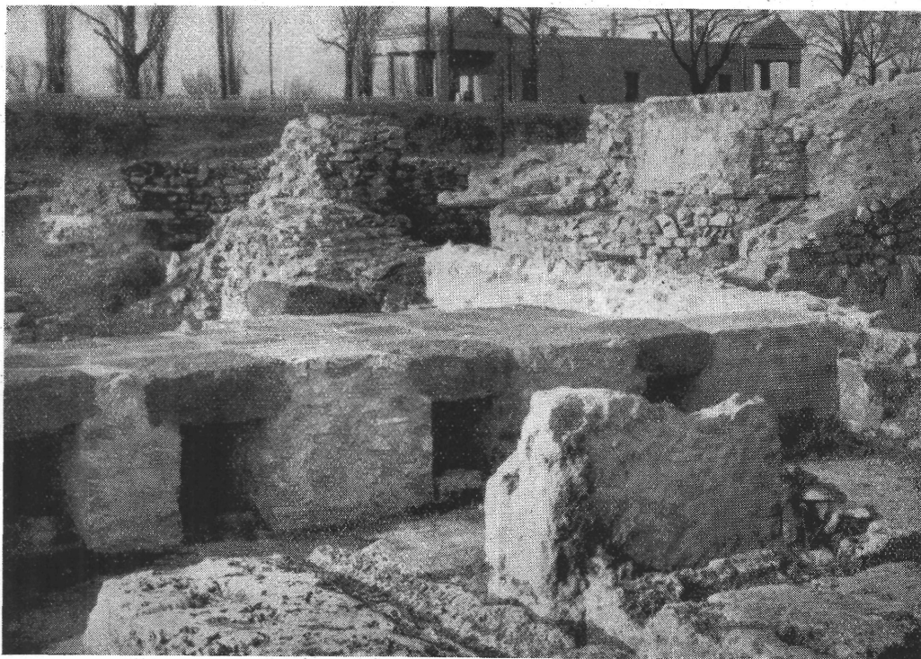
27. kép. — Az »I. közfürdő« izzasztóhelyiségéhez a hőlappadló alatti melegáteresztő nyílások.
