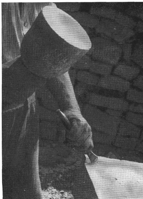
17. kép. Fogas véső használat közben L'emploi du ciseau bretté
