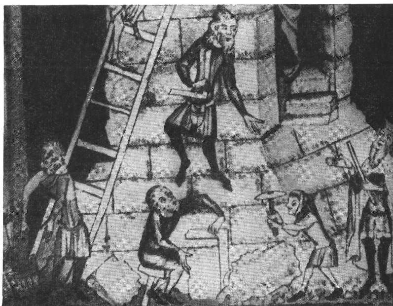
32. kép. Nagyolás hegyes kalapáccsal 1350 körül. Kézirat, Zürich
