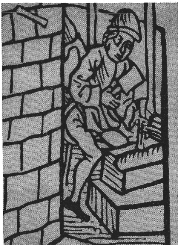
71. kép. Profilfaragás vésővel és bunkóval.
