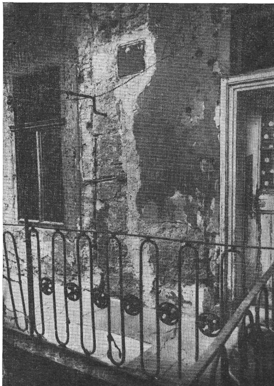
9a—b. kép. Az épület udvari homlokzatán a földszinten és emeleten feltárt sarokarmfrozás Die Eckarmierung, gefunden an der Hoffassade des Hauses (Erdgeschoss und erster Stock)
