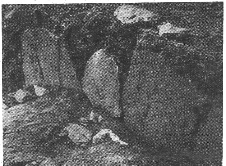
10. kép. Vakolat a középső traktus nyugati falán Mörtelbewurf an der westlichen Mauer des mittleren Traktes
