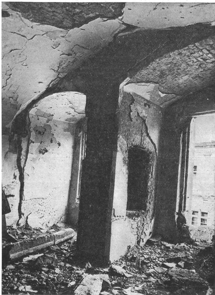
13. kép. Az épület utcai traktusának középkori konzolsort leterhelő, emeleti, kettős pillérállásai 1945-ben Die mittelalterliche Konsolenreihe des Straßentraktes des Gebäudes belastenden Doppelpfeilerstände des Stockwerkes. I. J. 1945.
