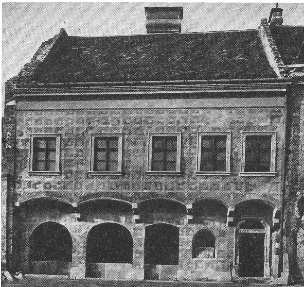
19. kép. Az épület helyreállított homlokzata 1954-ben. (Tervező: dr. Csemegi József és Czagány István) Hergestellte Fassade des Gebäudes i. J. 1954. (Entwurf von dr. J. Csemegi und I. Czagány)
