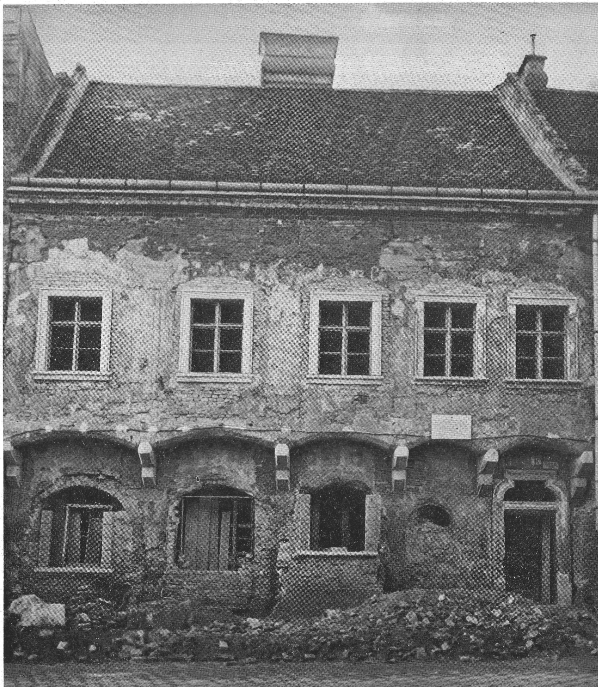
5. kép. Az épület utcai homlokzata a kutatások befejezésekor, a részleges helyreállítás közben 1953-ban Die Straßenfassade des Gebäudes beim Abschluß der Forschungen, bei der teilweise erfolgten Herstellung. I. J. 1953.
