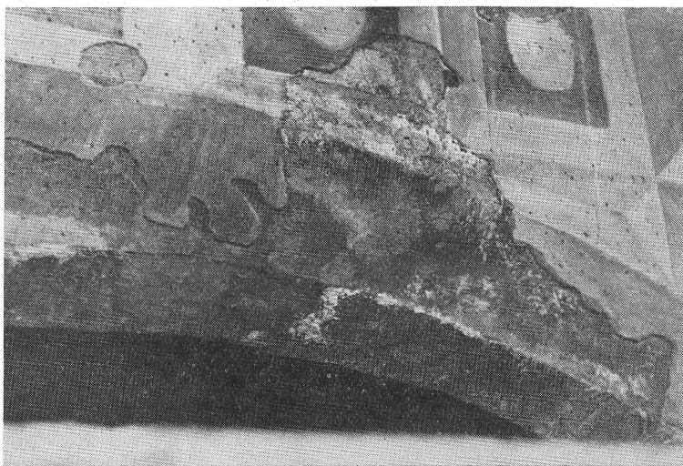
16. kép. Az épület homlokívének lecsökkentett szélességű bordürsávja helyreállítása után 1954-ben Der Bordürenstreifen der Fassadenbögen des Gebäudes von verminderter Breite nach seiner Wiederherstellung i. J. 1954.
