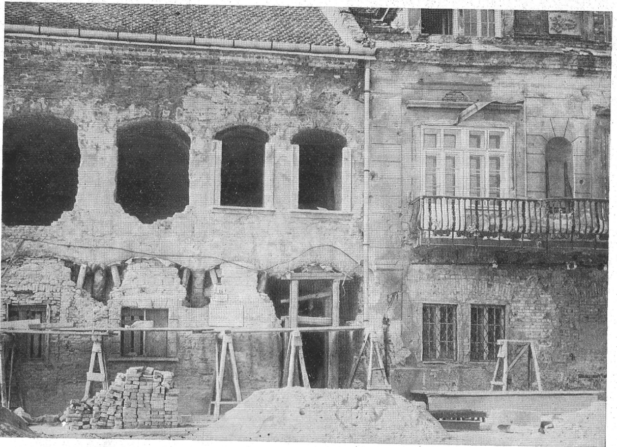
4. kép. Az épület utcai homlokzata műemléki kutatás közben a feltárt eredeti konzolcsomókkal, 1951-ben Die Straßenfassade des Gebäudes während der Denkmalforschung mit den freigelegten ursprünglichen Konsolschäften, i. J. 1951.
