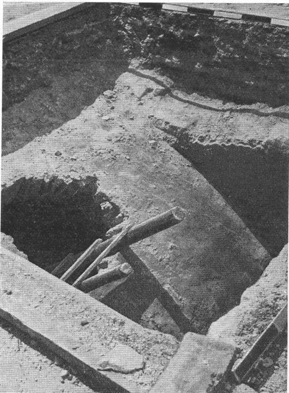
13. kép. „L/I” épület betört boltozata Das eingebrochene Gewölbe des Gebäudes „L/I”
