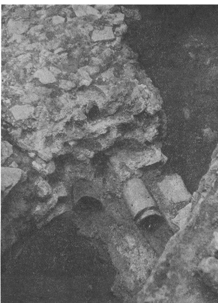
4. kép. III. Gyűrű u. 5. Kétcsövű római kori vízvezeték III. Bez. Gyűrű-Gasse 5. Zweiröhrige Wasserleitung aus der Römerzeit
