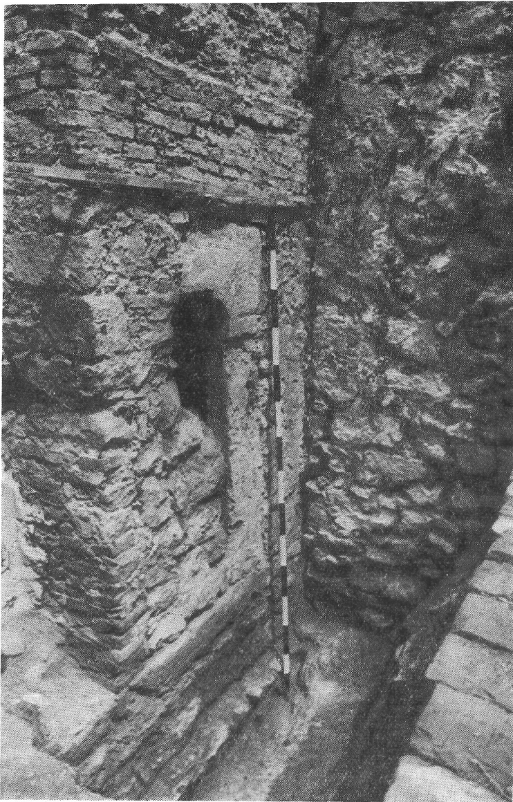
10. kép. Fortuna u. 18. Gótikus ajtó feltárása Fortuna-Gasse 18. Freilegung einer gotischen Tür
