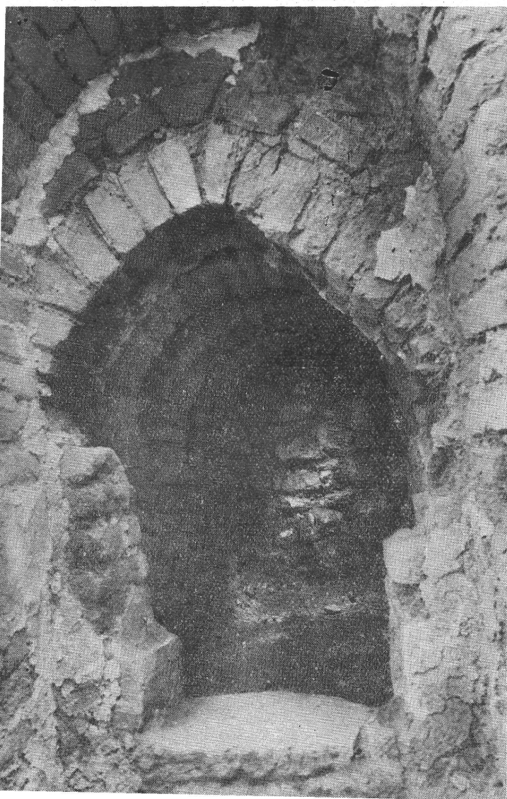
11—12. kép. Hess András tér 2. A domonkos kolostor XIV. sz.-i fűtőkamrája és annak kőkeretes fűtőnyílása Hess András-Platz 2. Heizkammer des Dominikanerklosters aus dem 14. Jahrhundert und ihre steinumfaßte Heizöffnung
