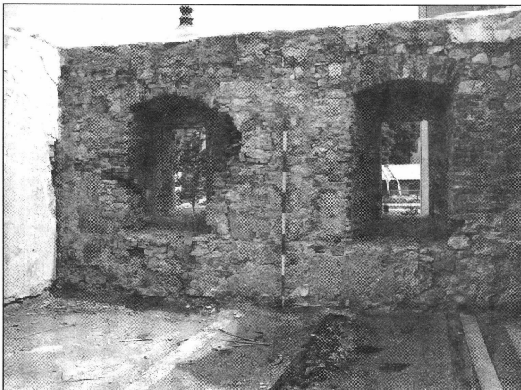
4. A középkori ház északi emeleti falában kibontott két gótikus ablak, délről
