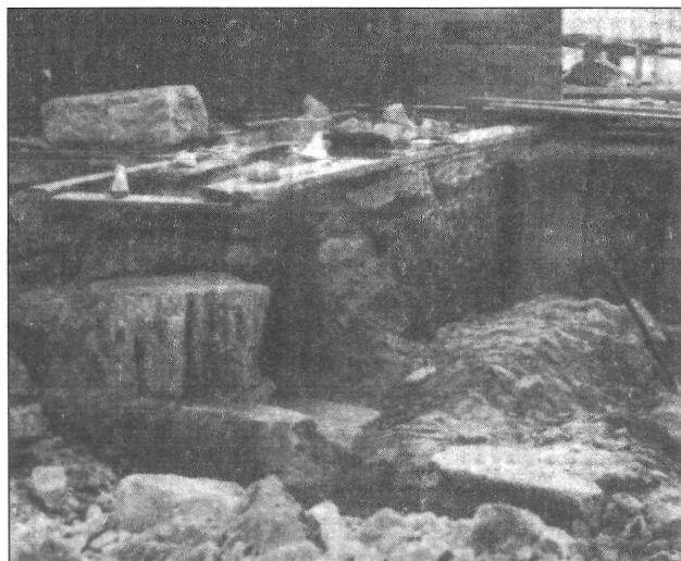
1. kép. Az Árpád-kori templom déli kapujának 1929-ben, a padlófűtés építése során eredeti helyén fellelt lábazati- és küszöbkövei.
