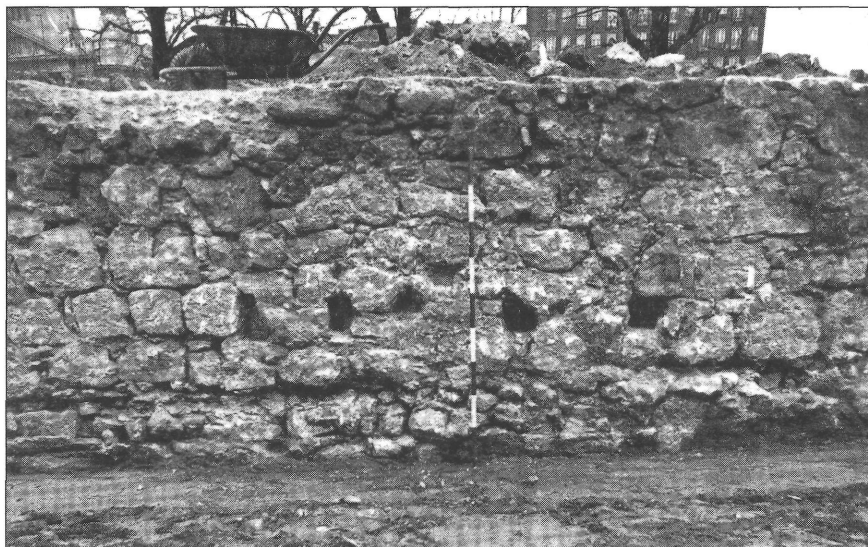
16. kép. Budapest V. Károly körút 28–30. A középkori városfalba épített gerendalyukak. 16. század.
