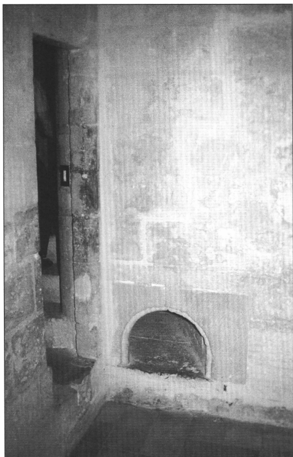
13. kép. A tarasconi vár fürdőjének ajtaja és hypocaustum-fűtőnyílása (14. század vége, 15. század eleje)
