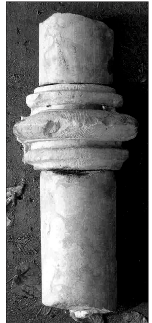
37. kép. Oszlopgyűrű és vörösmárvány oszloptörzsek összeállítása.
