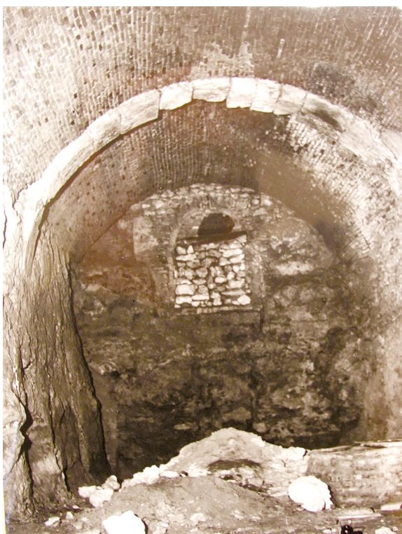
13. ábra – Az Üri utca 70. pince nyugati végének részlete a kőkeretes udvari pincelejáróval / Fig. 13 – Detail of the western end of the cellar at 70 Üri Street with the stone-framed courtyard cellar entrance (HU BFL XV. 17. e. 306. a - 730)
