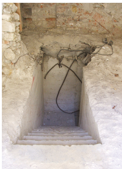
28. ábra – Az Úri utca 72. számú épület északi részében megtalált kőkeretes ajtó mögötti ferde téglaboltozat maradványa (felül) és átépített pincelépcső (balra, fotó: szerző, 2017. 05. 08.) / Fig. 28 – Remains of a slanted brick vault (top) and a rebuilt basement staircase behind the stone-framed door in the northern part of the building at 72 Úri Street (left, photo: author, on 8 May 2017) 29. ábra – Az Úri utca 72. északi fala mellett, a Kapisztrán tér alatt megtalált boltozatos pince nyugati vége (jobbra, fotó: szerző, 2016. 04. 20.) / Fig. 29 – The western end of the vaulted cellar found near the northern wall of 72 Úri Street, below Kapisztrán Square (right, photo: author, on 20 April 2016)
