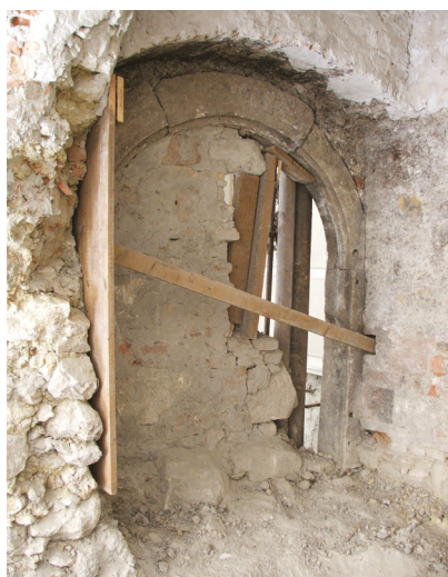
27. ábra – Az Úri utca 72. számú épület északi részében megtalált kőkeretes pinceajtó (fotó: szerző, 2017. 05. 08.) / Fig. 27 – The stone-framed cellar door found in the northern part of the building at 72 Úri Street (photo: author, on 8 May 2017)
