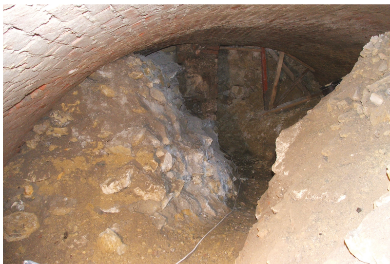
28. ábra – Az Úri utca 72. számú épület északi részében megtalált kőkeretes ajtó mögötti ferde téglaboltozat maradványa (felül) és átépített pincelépcső (balra, fotó: szerző, 2017. 05. 08.) / Fig. 28 – Remains of a slanted brick vault (top) and a rebuilt basement staircase behind the stone-framed door in the northern part of the building at 72 Úri Street (left, photo: author, on 8 May 2017) 29. ábra – Az Úri utca 72. északi fala mellett, a Kapisztrán tér alatt megtalált boltozatos pince nyugati vége (jobbra, fotó: szerző, 2016. 04. 20.) / Fig. 29 – The western end of the vaulted cellar found near the northern wall of 72 Úri Street, below Kapisztrán Square (right, photo: author, on 20 April 2016)
