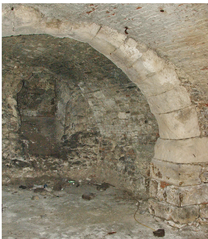
47. ábra – Az Országház utca 13. északi pincéjének kőíve, a háttérben a középkori utcai pincelejárát kőkerete (fotó: szerző, 2016. 05. 11.)
