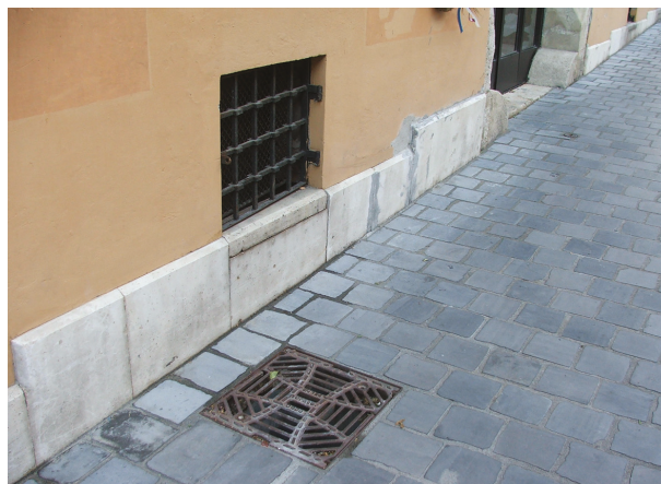
41. ábra – Az Országház utca 9. előtti járdában lévő barlangpince-szellőző (jobbra, fotó: szerző, 2013. 08. 11.) / Fig. 41 – The cave cellar vent in the sidewalk in front of 9 Országház Street (right, photo: author, on 11 August 2013)
