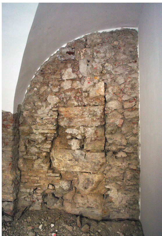
9. ábra – Az Üri utca 70. régi sarokarmírozása az Üri utca 72. felől (H-Y 2016, fényképmelléklet F97. kép) / Fig. 9 – The old quoining of 70 Üri Street on the side towards 72 Üri Street (image F97 from the photo appendix of H-Y 2016)
