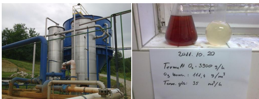
3. ábra: Ózon reaktor (bal) és fermentlé az ózonos kezelés előtt (barnás színű), ózonos kezelés után (áttetsző)
