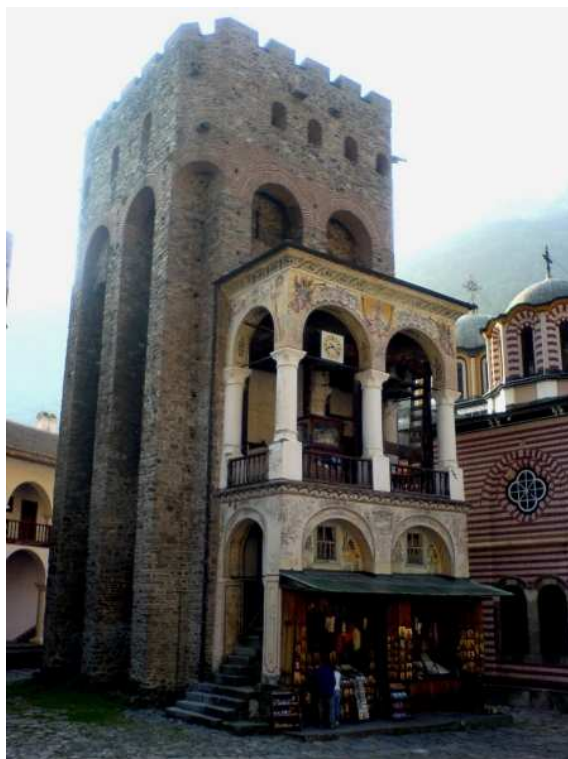
32. ábra: Rila, kolostor, Hreljo-torony
