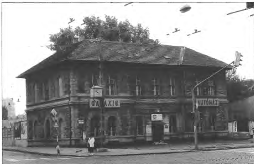
10. A Kőbányai úti vámház 1884-ben épült.
