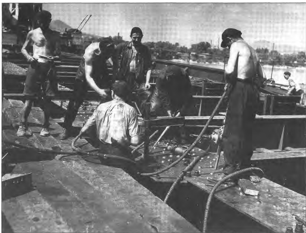
5. kép. Az Árpád híd vasszerkezetének szerelése, 1950 (fotó)
