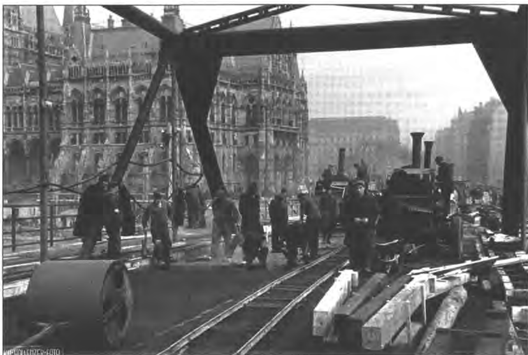
3. kép. A Kossuth híd hegesztett acélcsövekből és szegezett fatartókból álló szerkezetének építése, 1945 (fotó)
