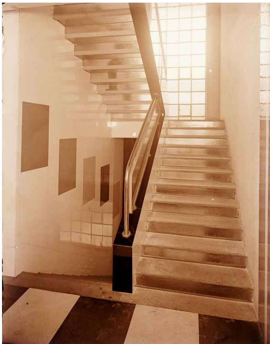
A belga üveglépcső a színes márványüveg falburkolatú lépcsőházban. Seidner Zoltán felvétele. Magyar Építészeti Múzeum
