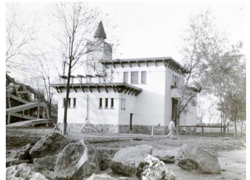
A zsiráfház építés közben, 1910. Fotó, Antony Gall tulajdona
