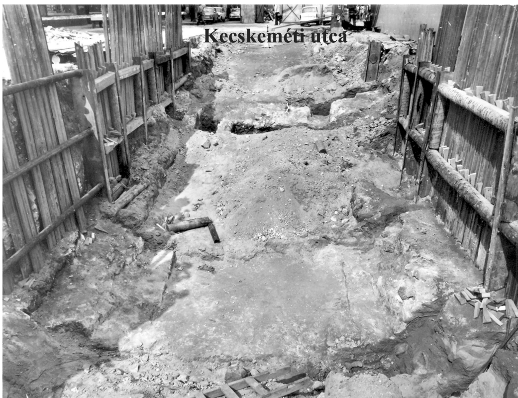
67. V. Kecskeméti utca 17–19. előtt, úttest. A METRO építkezés munkagödre a városkapu belső terében. Fotó M.I, 1972
