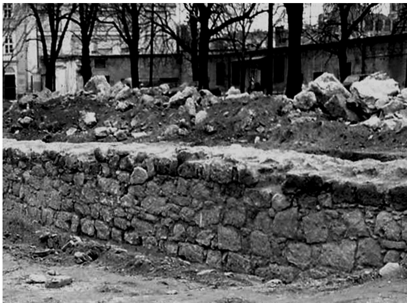
13. Budapest V. Károly körút 28–30. Falpótlások a szabályos kősorokból épített középkori városfalban. 1542. Fotó T.B., 1996
