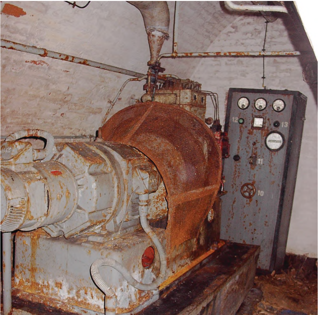
8. A régi, már működésképtelen dízel aggregát a barlangpince szinten. A Szerző felvétele 2006. 07. 22-én
