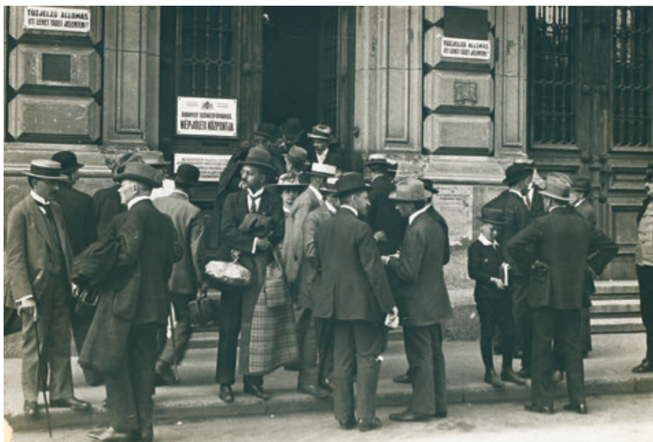
5. A Népjóléti Központ Főherceg Sándor utcai épülete előtt várakozók 1918-ban
