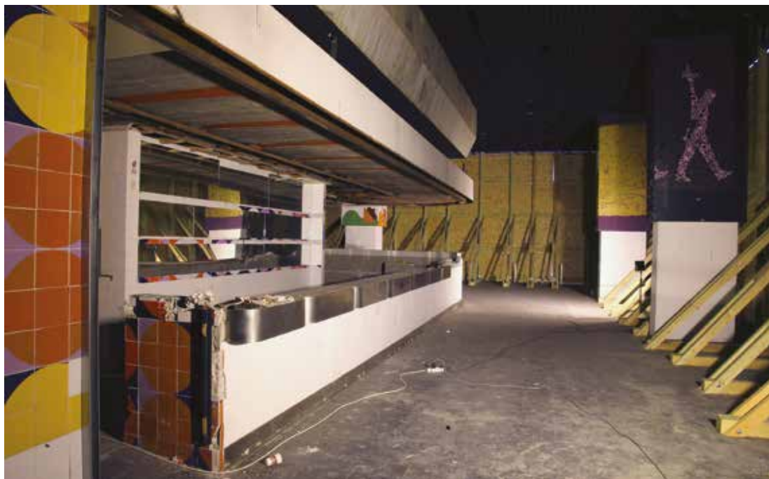
19. A volt sütemény- és kávépult az edzettüveg homlokzat-elemek elbontása után. F. Szalatnyay Judit felvétele, 2022. április
