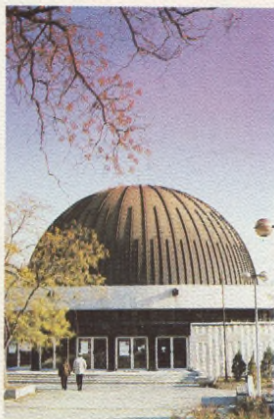
A Planetárium épülete
