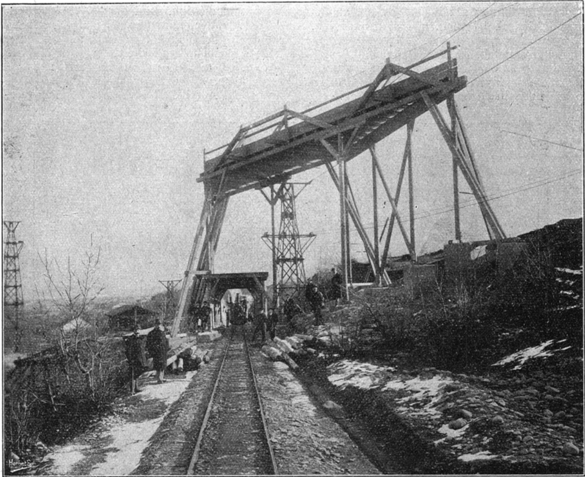
8. kép. Védőhid a zsieczy vasut fölött. A Pollacsek és Scheiber-féle, a kincstári kötélpálya és vasut egy pontban kereszteződnek. „A Bánya“ részére készült eredeti felvétel.
