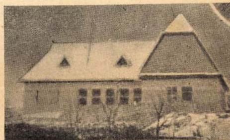
Az épülő háromtanerős nyárádgálfalvi iskolánk.
