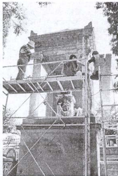
A kőanyag megszilárdítása után a nagyobb és kapilláris repedések kitöltése következett
