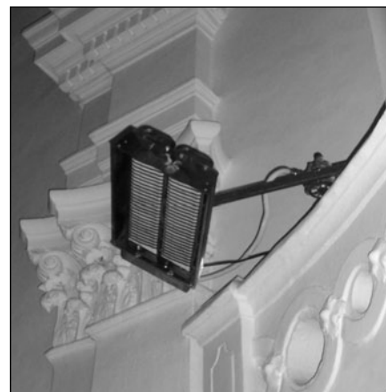
Gázműködtetésű infrasugárzó a kolozsvár-belvárosi unitárius templomban. A szerző felvétele
