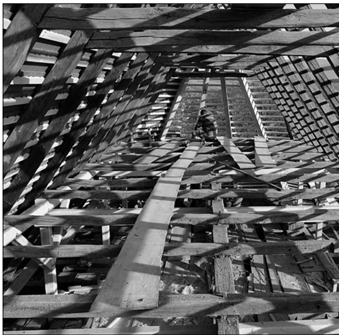
Tetőszerkezeti helyreállítás Medeséren
