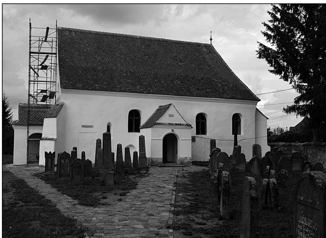
Befejezés előtt a templom külső felújítási munkálatai (2017)
