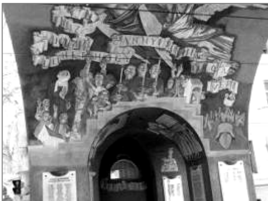
A Hősök kapuját bevakolása után fél évszázaddal kezdték el restaurálni.
