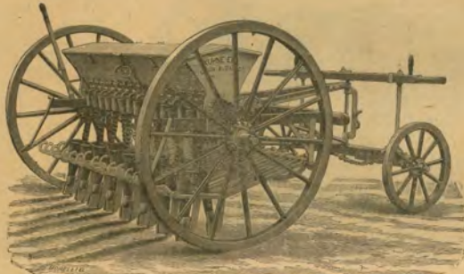
103. ábra. Kühne „Mosoni Drill” hegyi vetőgépe.
