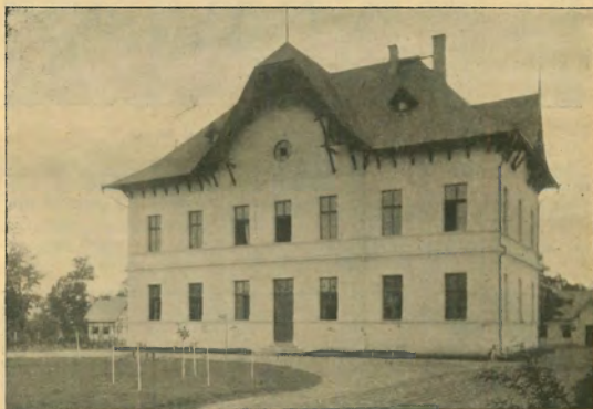
270. ábra. A gödöllői Iparoműviérszék-telep főépülete.
