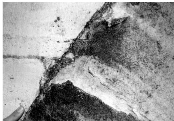
1. ábra. Leváló fekete mállási kéreg alatt feltáródó, gyorsan pusztuló durva mészkő
