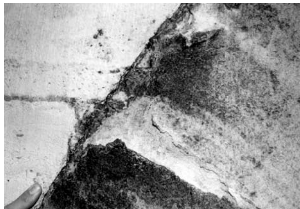
1. ábra. Leváló fekete mállási kéreg alatt feltáródó, gyorsan pusztuló durva mészke
