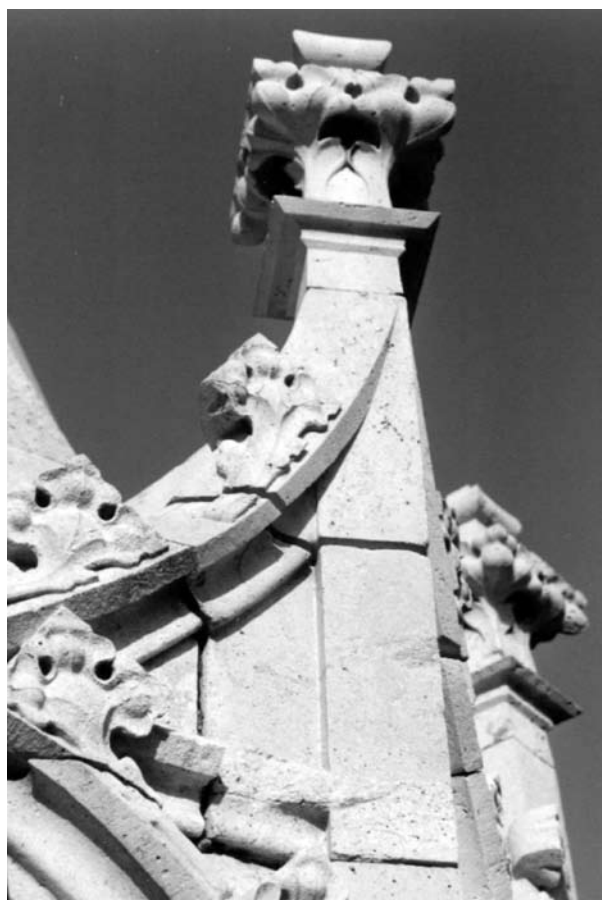
2. ábra. Szétnyíló fugák a toronyban
