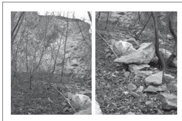
5. ábra. Jellemző képek a falszakaszról és a fal alatti, leszakadt kőzettömbökről Characteristic pictures of the quarry wall with tumbled down blocks of rock
