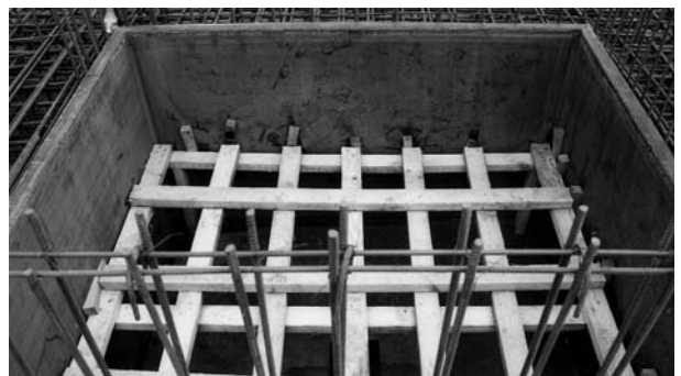
5. ábra. Acéllemez szigetelés Fig. 5. Steel plate insulation
