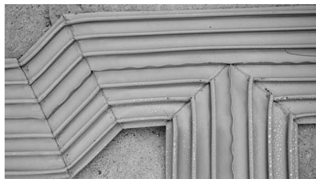
3. ábra. Toldás sütőökkel Fig. 3. Butt-joints with melted wedges
