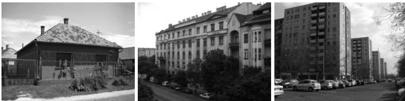
Fig. 1-2-3. Examples of the elements of the building stock: 'One-storied family house from 1945–1990'; 'Pre-war downtown tenement block' and 'High-rise prefabricated housing block' 1-2-3. ábra Példák a hazai épületállományra: az ún. „Kockaház”, a „Belvárosi bérház” illetve a „Magas panelház”
