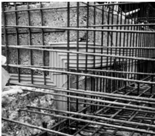
4. ábra Sika PVC fugaszalagok beépítve
