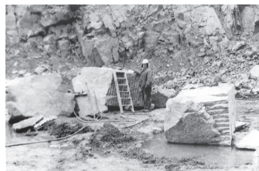
19. ábra A gránittömbök gépi feldolgozásra alkalmassá faragása a mélyszinten Fig. 19. Carving of granite blocks at the deep level of the pit; preconditioning for mechanical processing
