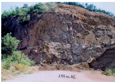
15. ábra Bányafal omlás a 177 méteres szint (Bf.) északnyugati falszakaszán Fig. 15. Pit wall collapse at the North-West section of the 177 m.Bf. extracting bench
