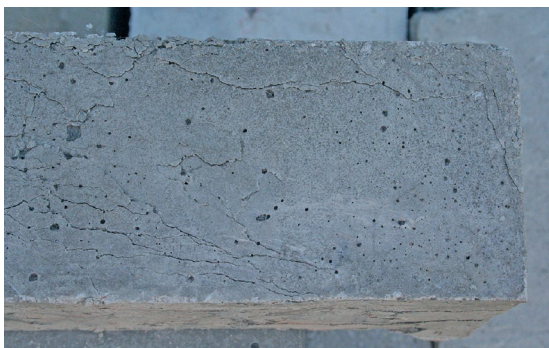
Fig. 3. Damaged specimen after 10 freeze-thaw cycles 3. ábra Próbatest károsodása 10 fagyasztás-olvasztás ciklust követően
