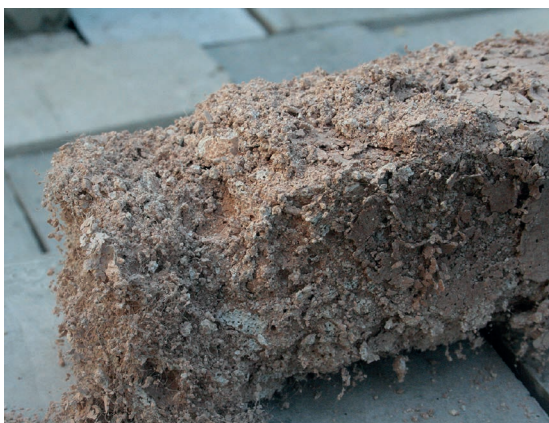
Fig. 4. Damaged specimen after 25 freeze-thaw cycles 4. ábra Próbatest károsodása 25 fagyasztás-olvasztás ciklust követően
