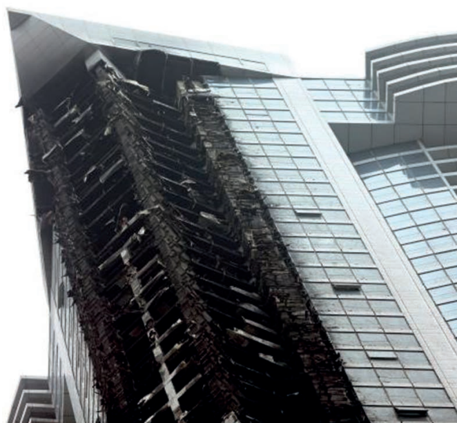
1. ábra Kikötői fáklya nevű 79 emeletes lakóház tüzesete Dubaiban [2] Fig. 1. The 79 floor Torch residential tower in Dubai after fire [2]
