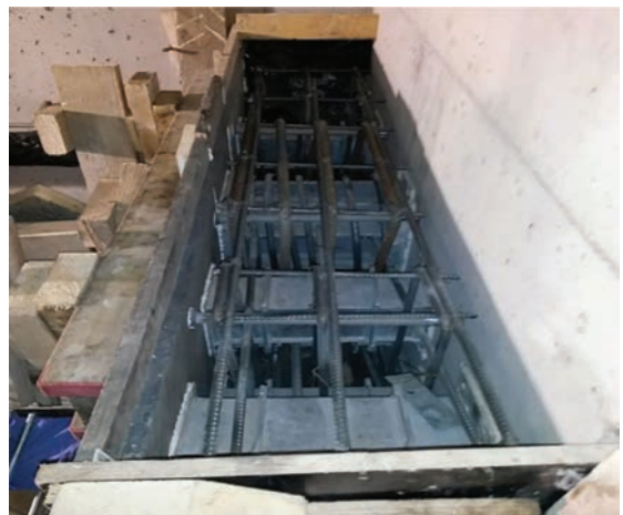
Fig. 6.a. Formwork section close up 6.a ábra Zsaluzat kialakítása
