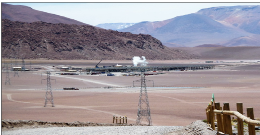
1. A geotermikus erőmű látképe, mögötte a Cerro Pabellón vulkán egy része
