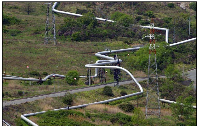
A tájban kanyargó vezetékrendszer
