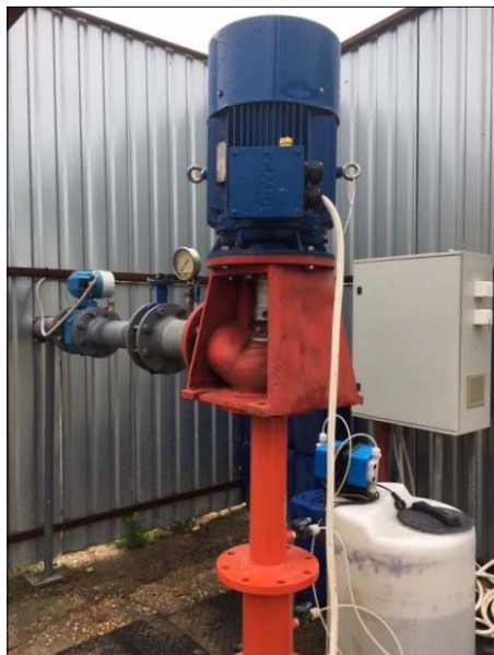
Az egyik termálkút, hosszútengelyes szivattyúval, inhibitor adagolóval
