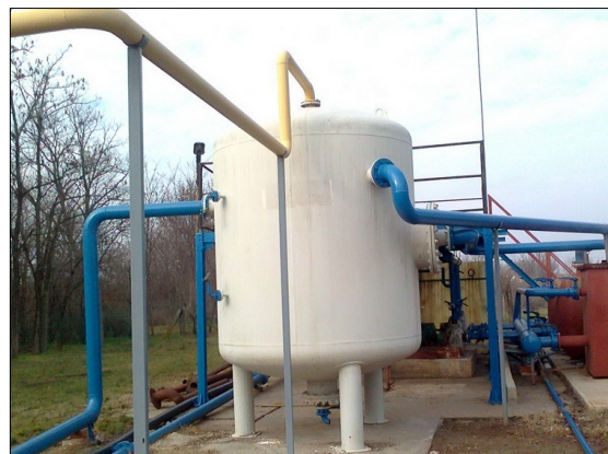
Kísérőgáz leválasztására szolgáló tartály
