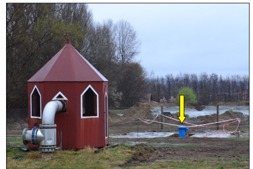
A Csomádi úti új visszasajtoló kút (sárga nyíllal jelölve), előtérben a K-23 sz. régi visszasajtoló kút a kútházikóval
