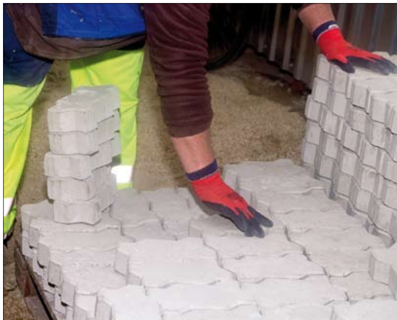
Az elkészült térkövekből hamarosan járda épül
