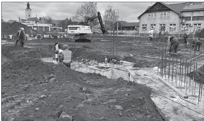
Zajlik a rendezvényközpont alapozása
