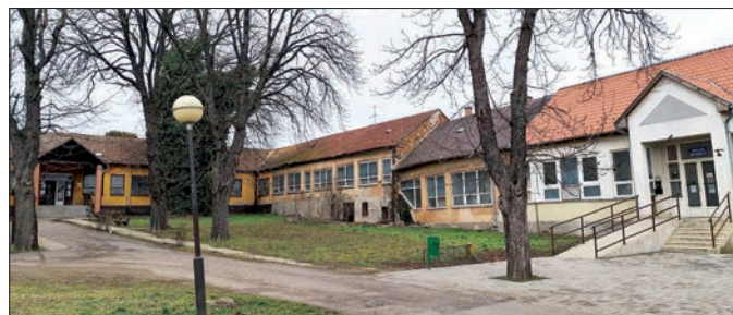
Ráfér a felújítás a Debreceni úti épületegyüttesre
